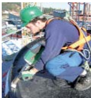
Мощный WELDPLAST S4 в работе.
