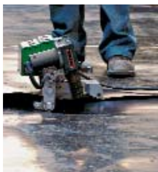
TWINNY T с комбинированным клином при сварке геомембраны из ПЭНД.
