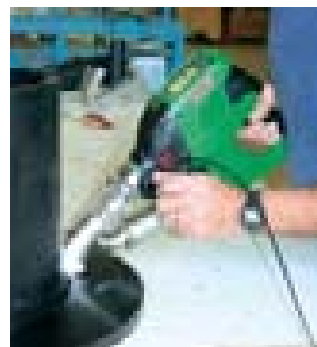
Сварка трубы аппаратом WELDPLAST S2
