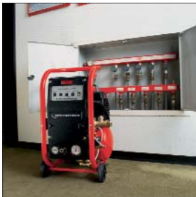
Промывка системы отопления пола
