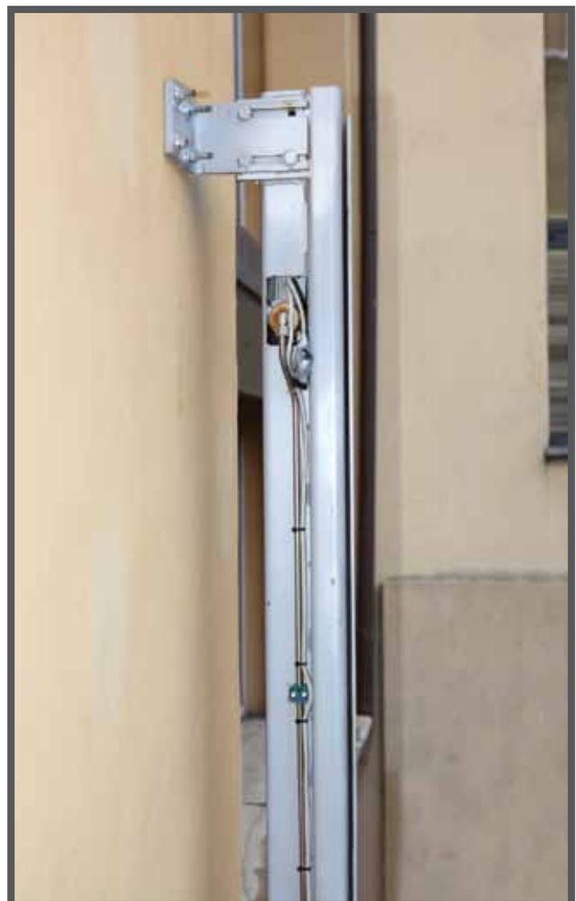
Колонны крепятся к стенам при помощи кронштейнов и химических анкеров. Такой способ обеспечивает наибольшую надёжность.
