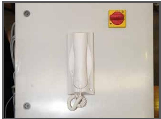
Щит питания обычно устанавливается на стене над гидравлическим блоком. На фотографии показана также телефонная трубка, которая используется для связи с коммуникатором, установленным на платформе.
