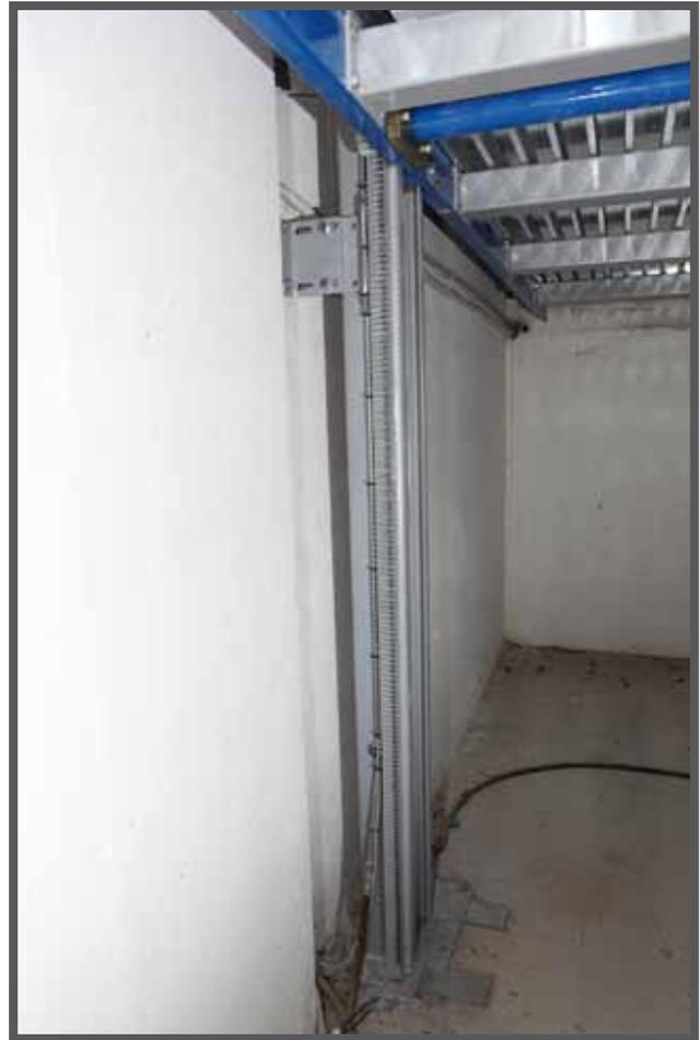
Колонны крепятся к стенам при помощи угловых стальных кронштейнов с отверстиями, что гарантирует повышенную устойчивость и безопасность системы.
