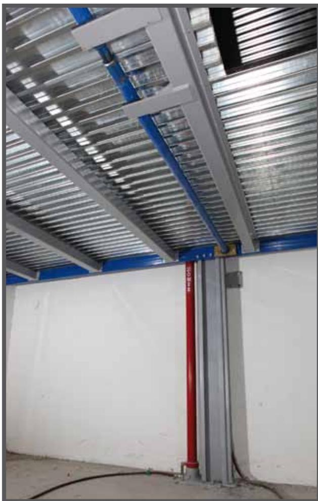
Торсионная балка состоит из двух секций, закрепленных посередине механическим соединением.
