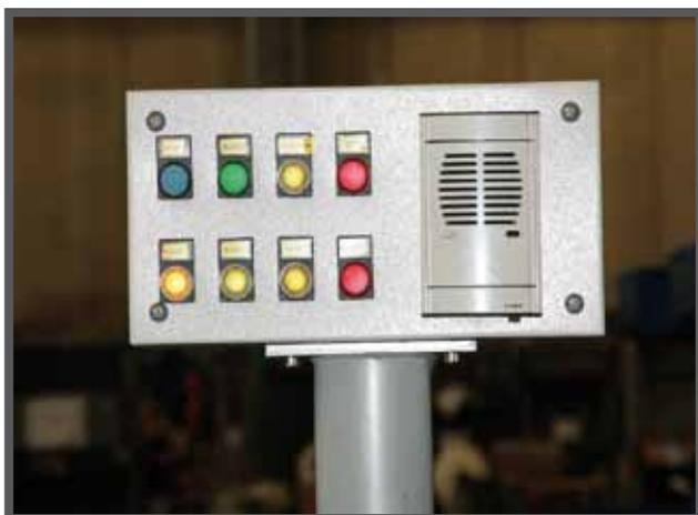
На пульте управления имеются обычные органы управления, предназначенные для перемещения лифта на нужный этаж, а также кнопка аварийного останова и кнопка коммуникатора, которая позволяет связаться с внешним миром (используется встроенный в систему телефонный аппарат).
