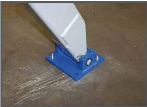
Неподвижная часть рамы также закреплена на полу механическими анкерами и соединяется с опорами шарнирами с износостойкими пластиковыми втулками. Это также позволяет увеличить срок службы системы.
