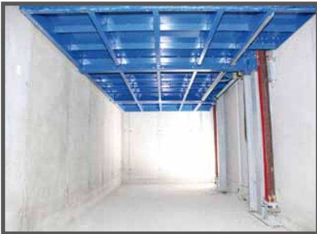
Благодаря этой системе нагрузка распределяется по всей площади платформы, что позволяет использовать ее для подъема грузов и автомобилей, даже если они смещены от центра подъемника.
