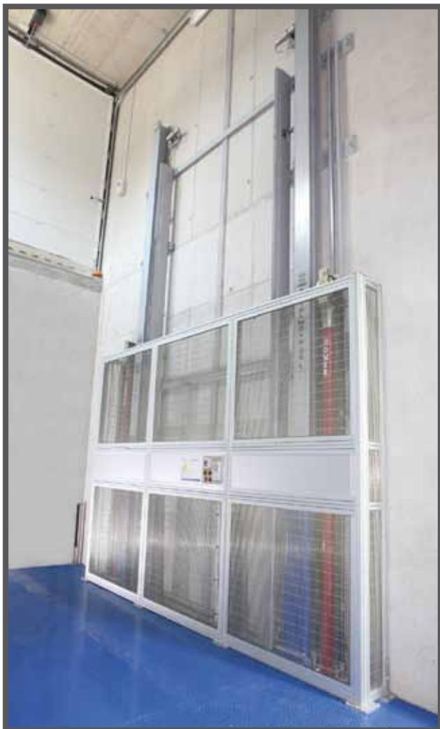
Платформа оснащена защитным ограждением высотой 2,5 м, которое может быть демонтировано только с использованием специального инструмента и предотвращает контакт с движущимися частями системы во время перемещения платформы (в соответствии с требованиями ЕС 2006/42).
