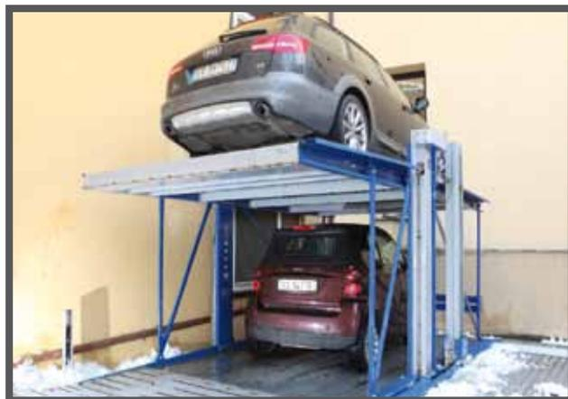
Система Move 20/2 представляет собой независимую двухъярусную парковочную систему, на которой может быть припарковано два автомобиля. При этом любой из них может быть оперативно, без каких-либо ограничений и препятствий, выведен за пределы парковки, независимо от нахождения на ней другого автомобиля.
