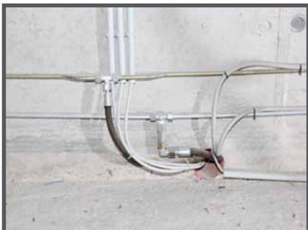
На фотографии показано, насколько просто монтировать электрические и гидравлические магистрали системы, расположенные в приямке ниже платформы, между двумя опорами.
