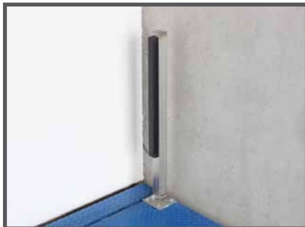
На коротких сторонах платформы имеются фотоэлектрические барьеры, каждый из которых состоит из двух фотоэлектрических датчиков, которые блокируют платформу в случае внезапного перемещения автомобиля или возникновения опасности его соприкосновения со стеной. Благодаря этой особенности можно гарантировать, что автомобиль всегда будет расположен правильно.
